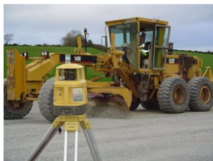
Równiarka z zainstalowanym systemem 3D mmGPS firmy Topcon
