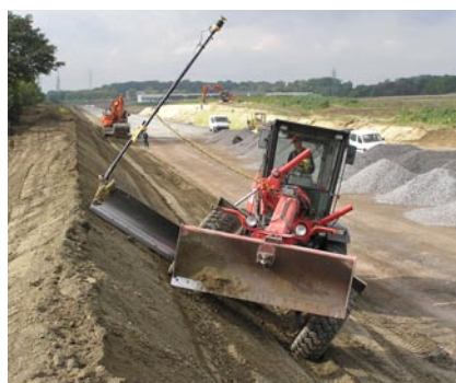
Praca na podstawie projektu cyfrowego pozwala realizować dokładnie niemal dowolne płaszczyzny. Równiarka z systemem 3D mmGPS niweluje skarpe
