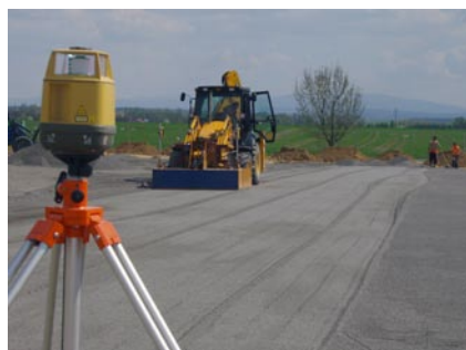
System leveller na koparkoladowarce. Na pierwszym planie niwelator laserowy
