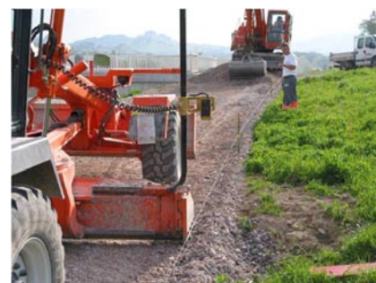
Efekt zastosowania systemu widoczny jest już po pierwszych przejazdach równiarki
