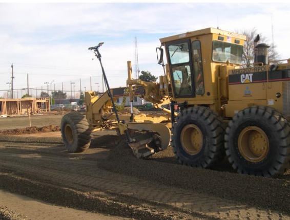
Równiarka CAT z systemem 3D GPS podczas pracy
