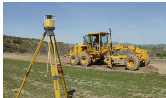
Większą dokładność pomiarową system 3D GPS uzyskuje po rozszerzeniu o opcję Topcon mmGPS
