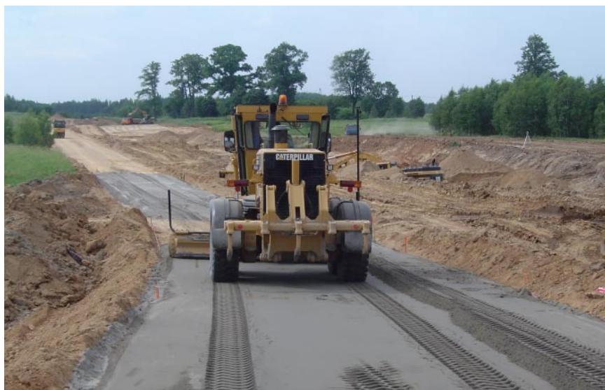
Równiarka z systemem Topcon 3D LPS podczas pracy
