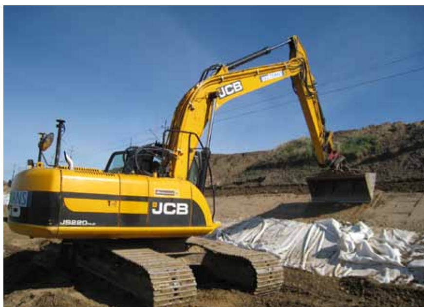
Wykonywanie nasypów i skarp z nowym systemem Topcon X-33
