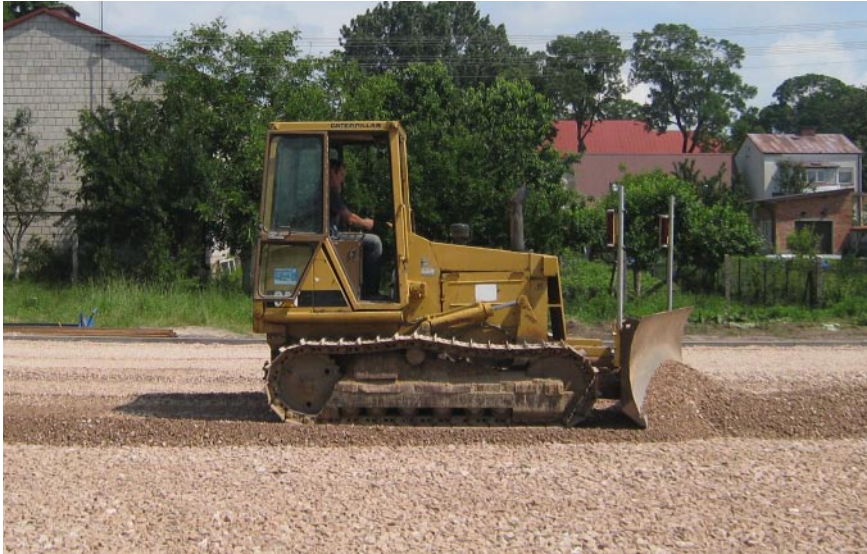
Spycharka z czujnikiem może obrabiać dowolnie nachyloną powierzchnię z dokładnością ok. \pm 1,5 cm
