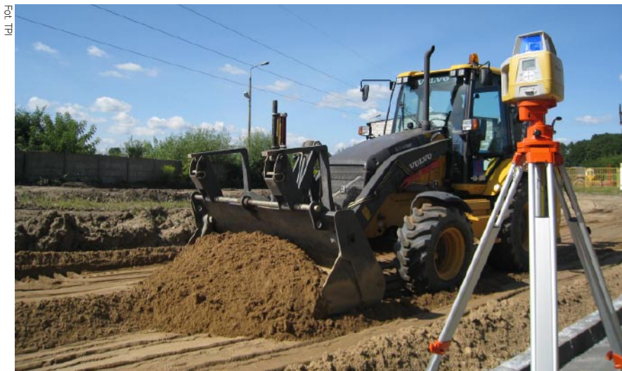
System Topcon do laserowej kontroli pracy można bez problemu używać np. na koparkoladowarce
