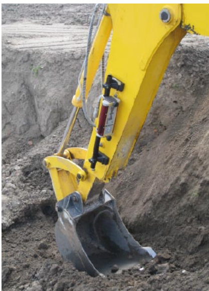
Operator koparki dzięki czujnikowi na ramieniu ma pełną kontrolę nad głębokością wykopu
