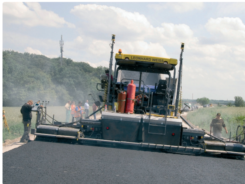
Fot. Obok: rozściełacz z systemem AutoPave (3D mmGPS). Powyżej: panel sterujący.
