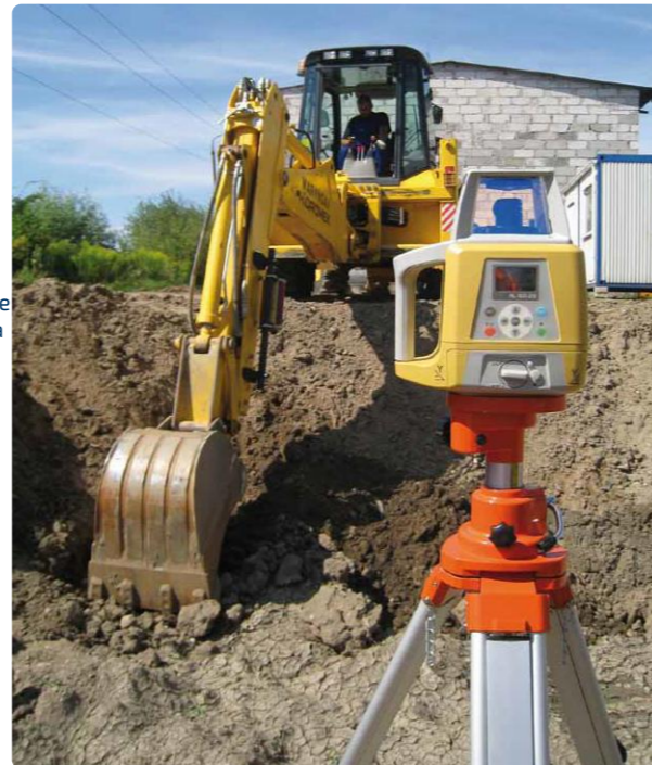
Kontrola głębokości wykopu za pomocą lasera i czujnika zamocowanego na ramieniu koparko-ładowarki.
