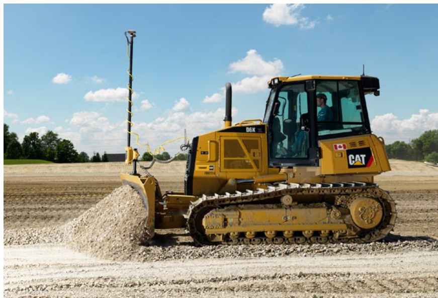
Spycharka z zainstalowanym systemem Topcon 3D MC 2
