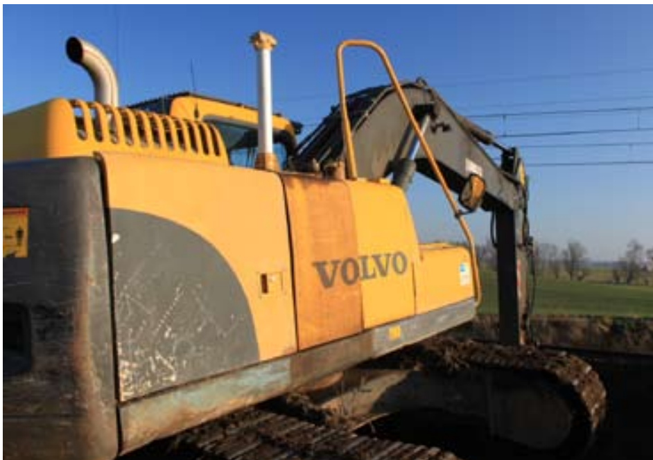
System Topcon X22 zabudowany na koparce pomaga w renowacji nasypu kolejowego
