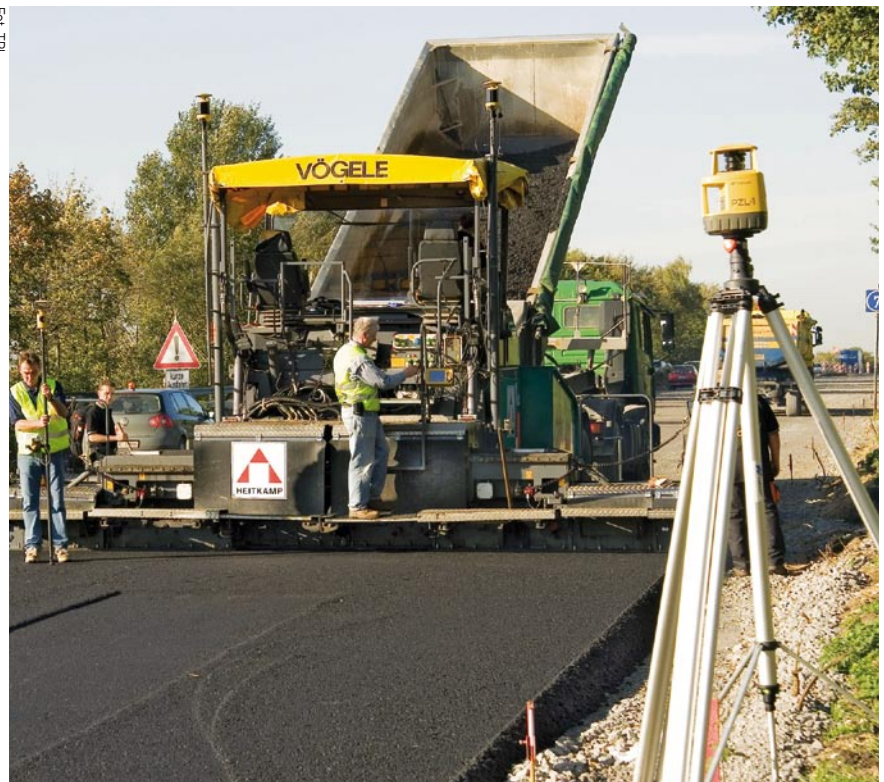
Nadajnik LazerZone (widoczny z prawej) emituje wiązkę lasera o wysokości 10 m na odległość 300 m
