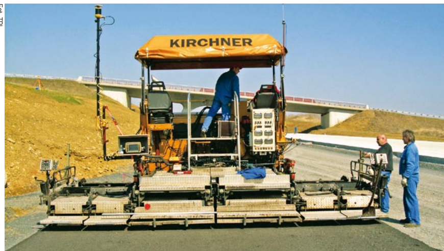
W systemie 3D mmGPS odbiornik GPS RTK został uzupełniony o nadajnik LazerZone i specjalny odbiornik mmGPS zamocowany na maszcie
