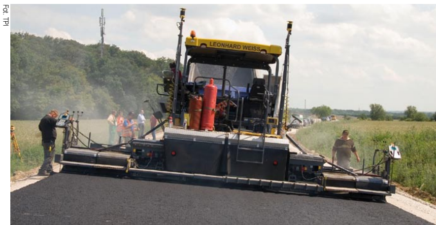
Rozwiązanie Topcon 3D mmGPS pozwala realizować również powierzchnię o dowolnym nachyleniu
