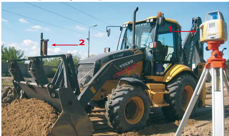
Spychanie, niwelacja: (1) niwelator laserowy, (2) czujnik
