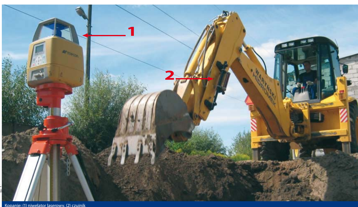
Kopanie: (1) niwelator laserowy, (2) czujnik
